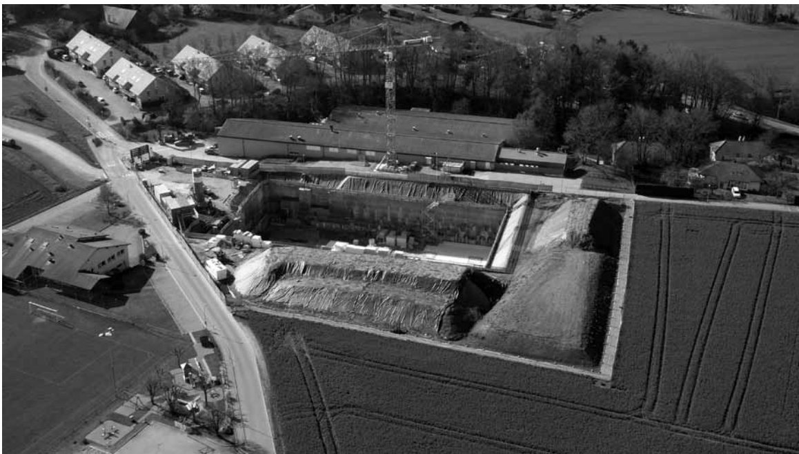
Vue aérienne générale de Penthaz I et l'excavation pour l'extension de Penthaz II (Photo: C. Dimitriu)
