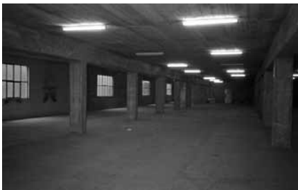
Locaux du rez-de-chaussée inférieur du bâtiment.
